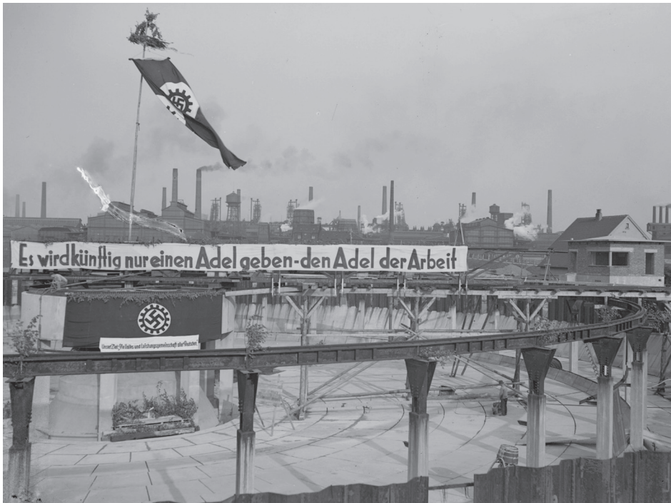
Abb. 2: Aufnahme der Baustelle an der Kläranlage „Alte Emscher“, auf deren Richtfest 1935 weithin sichtbar ein Banner der Deutschen Arbeitsfront mit der Losung „Es wird künftig nur einen Adel geben – den Adel der Arbeit“ angebracht wurde. 36
