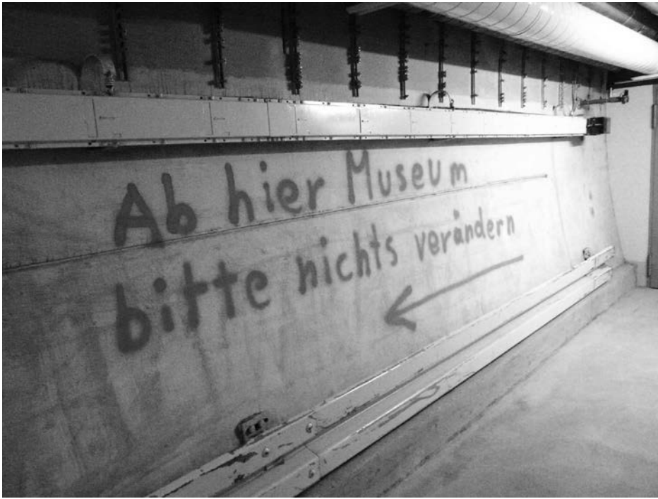
Abb. 1: Seit 2008 sind 203 Meter des 17.336 Meter langen Bunkerstollens als „Dokumentationsstätte Regierungsbunker“ musealisiert 16
