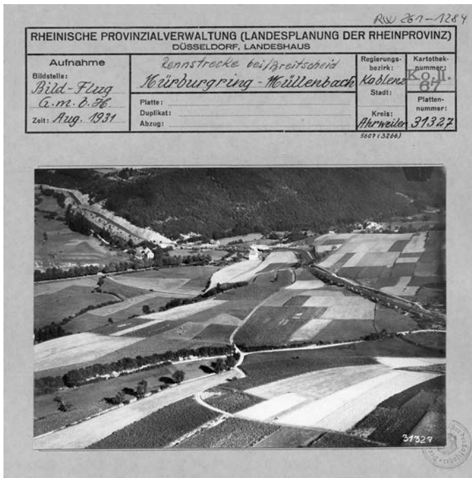
Abb. 2: Nürburgring – Müllenbach, Rennstrecke bei Breitscheid, August 1931 67
